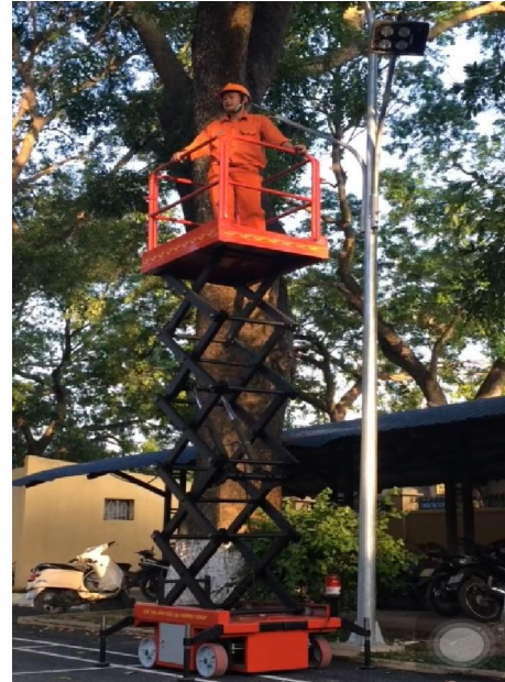
Hình 5. Thử nghiệm nâng hạ lắp điện chiếu sáng
