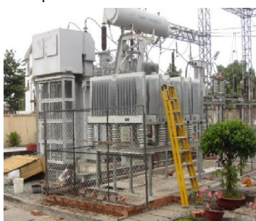
Hình 6. Thiết bị R-FCL lắp đặt thực tế tại TBA 110kV Bình An (thông số thiết bị & thực tế lắp đặt)
