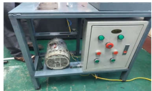
Hình 6. Lắp động cơ điện
