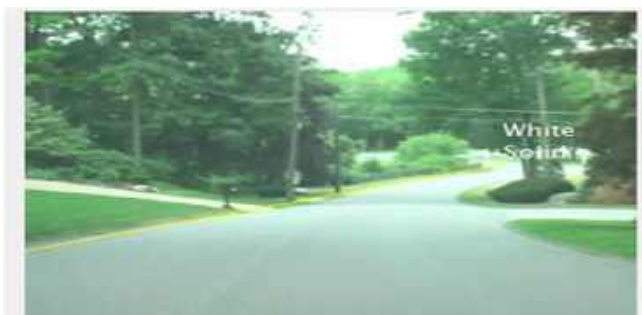
Hình 8. Làn đường không có vạch kẻ đường
